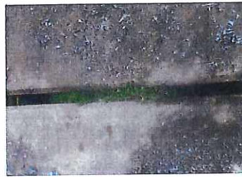
Abb. 35: Bewuchs in einer Koppelfuge der Elemente
