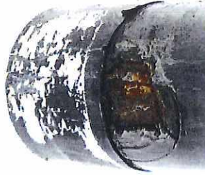
Abb. 53: Schadhafter Kopf eines Festmacherpfahls.
