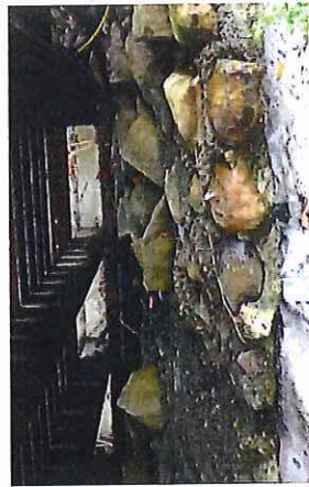
Abb. 4: Nördliches Auflager des hölzernen Steges
