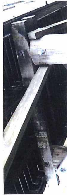
Abb. 65: Jochbalken im Stegbereich
