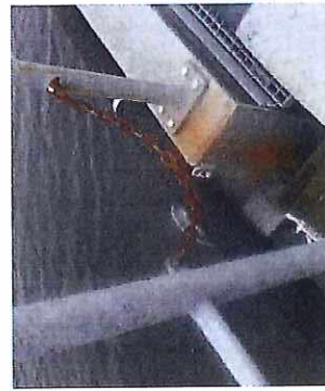
Abb. 24: Korrosion an den Ketten am nördlichen Ende des östlichen Hauptträgers
