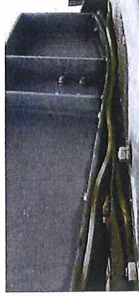
Abb. 26: Stütliches Auflager der Zugangsbrücke auf dem Schwimmstegelement
