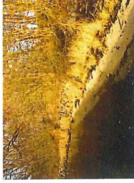
Abb. 103: Böschung westlich des Auslaufbauwerks
