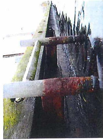
Abb. 7: Steigleiter ohne Haltebügel
