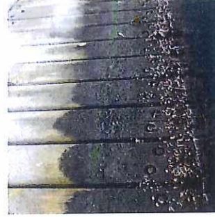
Abb. 67: Schürze aus Holzbohlen 5/14 cm an der Nordseite bei ca. 20 cm Niedrigwasser
