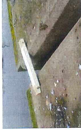
Abb. 37: Tieferliegende Nordostecke des Elementes Nr. 6
