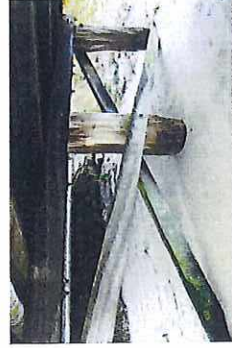
Abb. 18: Auskreuzung des nördlichen Auflagerjoches
