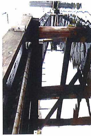
Abb. 3: Südliches Auflager des hölzernen Steges
