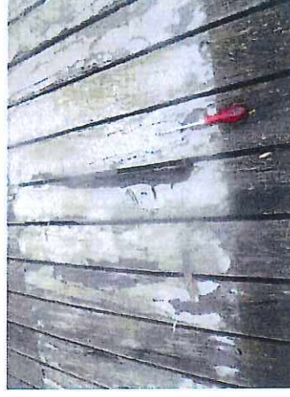
Abb. 10: Bohlenbelag des Holzsteges mit Anstrich
