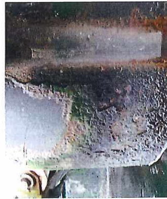
Abb. 45: Dalbenpfahl mit schadhafter Beschichtung und Blattrostbildung knapp über der Wasserlinie
