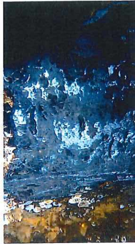
Abb. 88: Stahloberfläche eines gereinigten Gründungspfahl unter Wasser.
