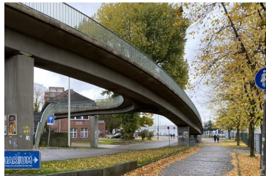
Fußgängerbrücke Südlicher Eingang Kiellinie
