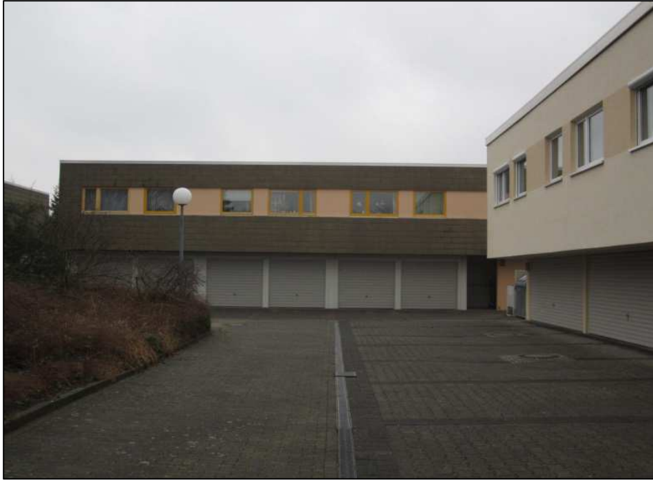
Abbildung 5 Ansicht Straßenseite (Garagen)
