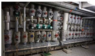
Heizkreisverteiler Schwimmbad
