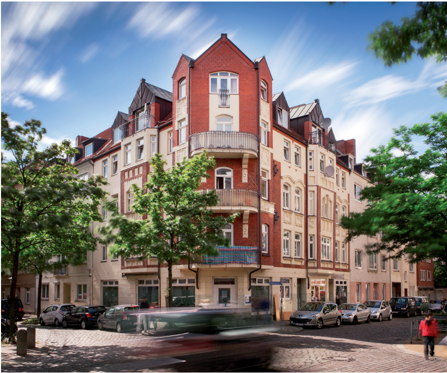
Erhaltenswerte Gebäudefassaden in Zentrales Gaarden
